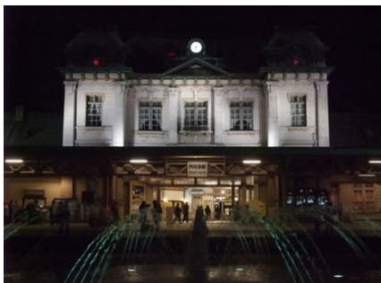
ライトアップされた夜の門司港駅舎 この駅から最後の旅が始まる
